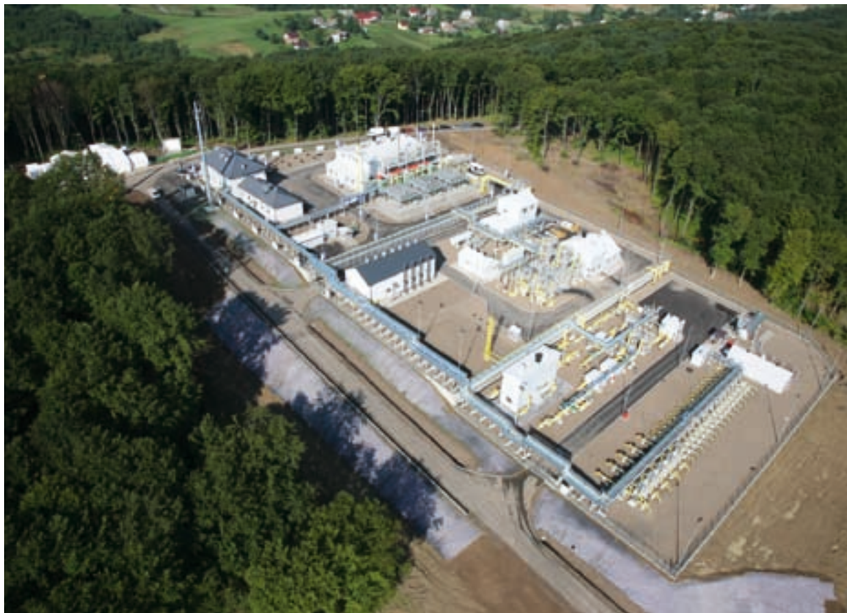
Podziemny magazynu gazu w Strachocinie (fot. PGNiG SA)
